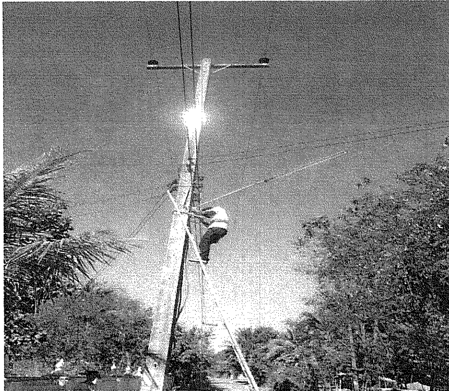
รูปภาพซ่อมไฟฟ้าส่องสว่าง บ้านสองห้อง หมู่ที่ ๗
